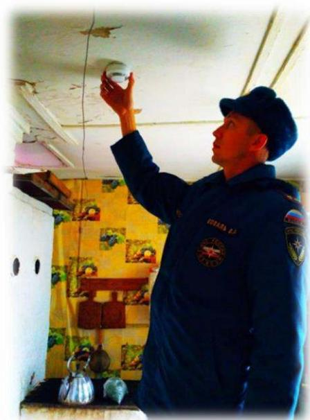
пожарно-технической продукции, выпускаемой на сегодняшний день как отечественными, так и зарубежными производителями, наиболее подходящим устройством для применения в индивидуальном жилье являются автономные дымовые пожарные извещатели со встроенным GSM модулем.
